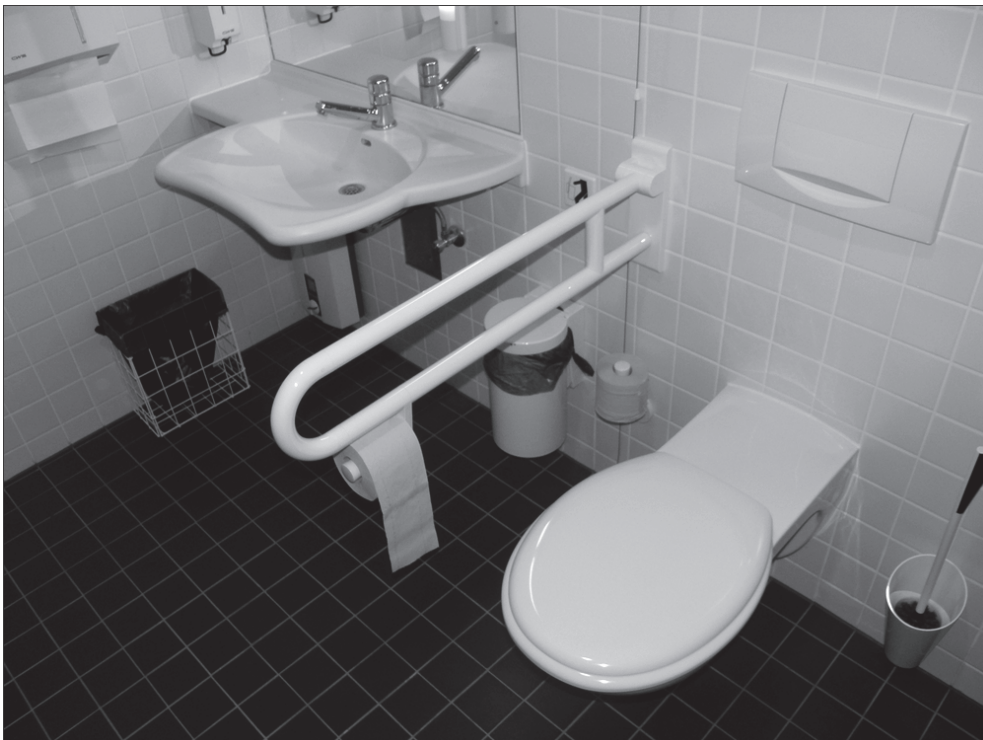
Bezbariérové úpravy - toalety
