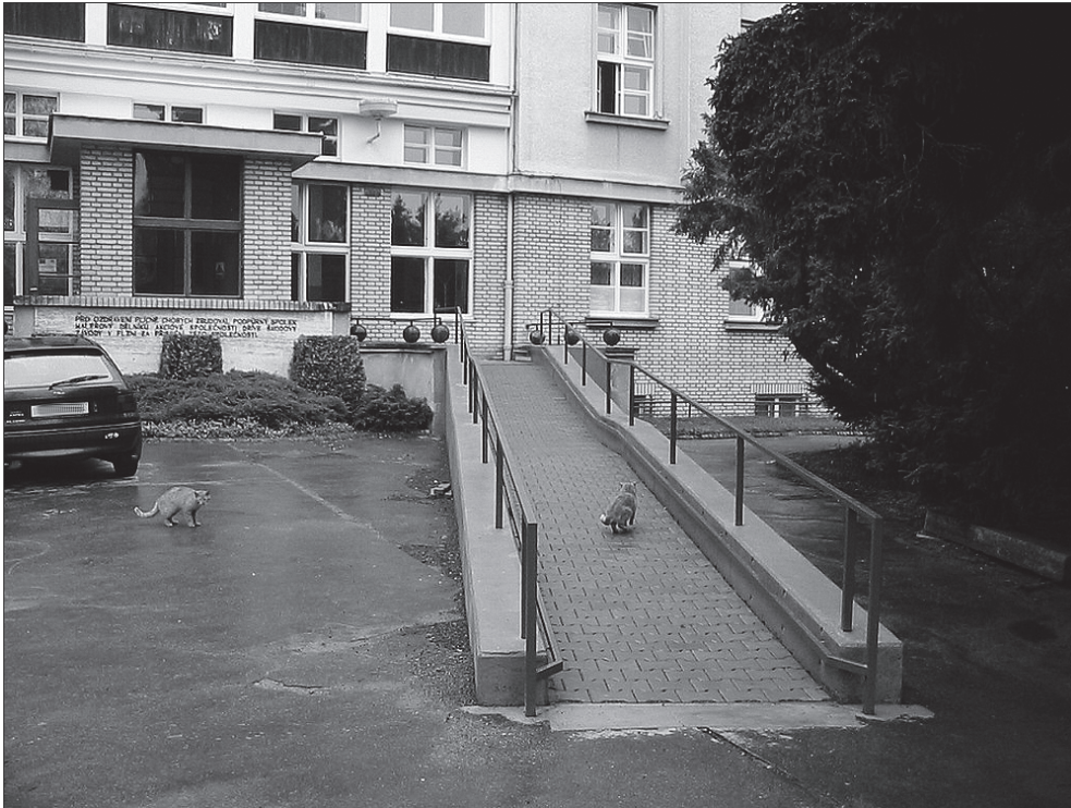
27.2 Bezbariérové úpravy - rampa
