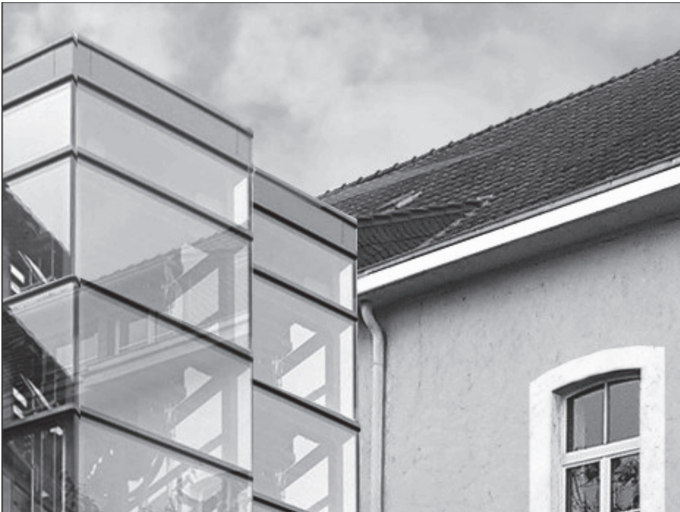
Bezbariérové úpravy - výtah
