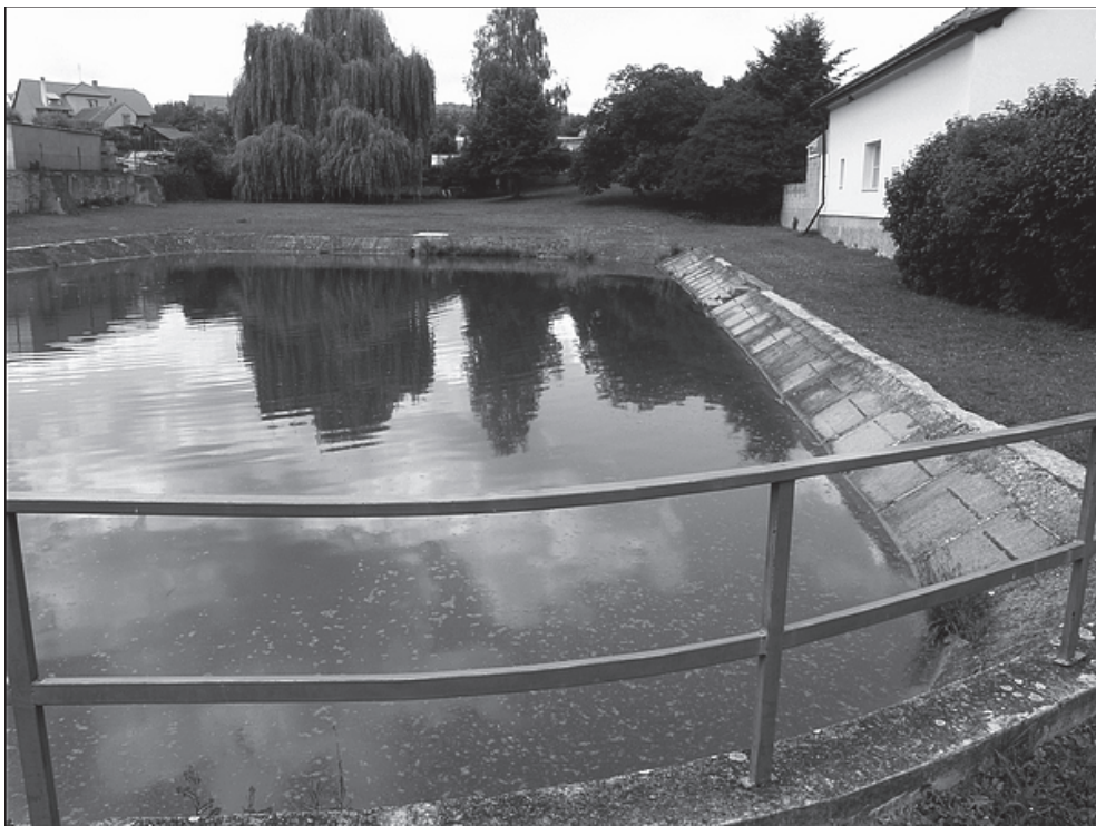
F10 – požární nádrž
